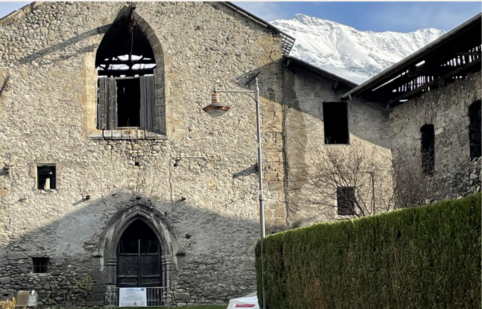
La façade de l'église et son portail gothique, vus de la Grande Rue
