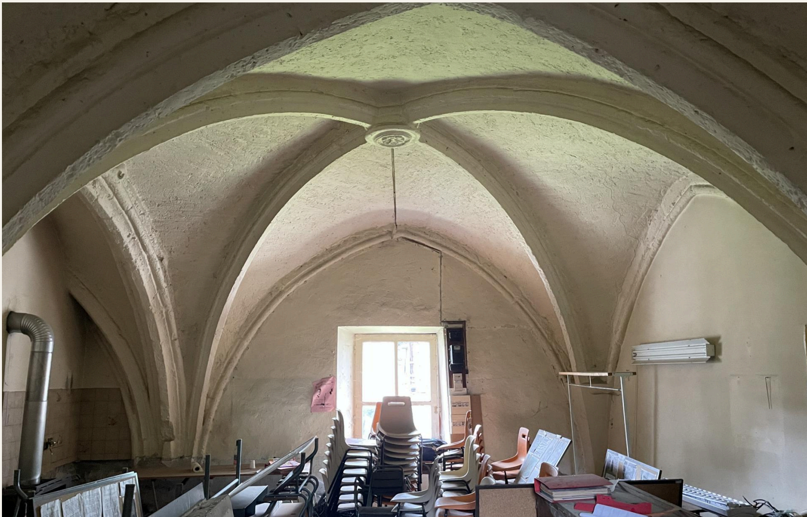
Les voûtes d'ogives en tuf de la salle capitulaire, XV e siècle
