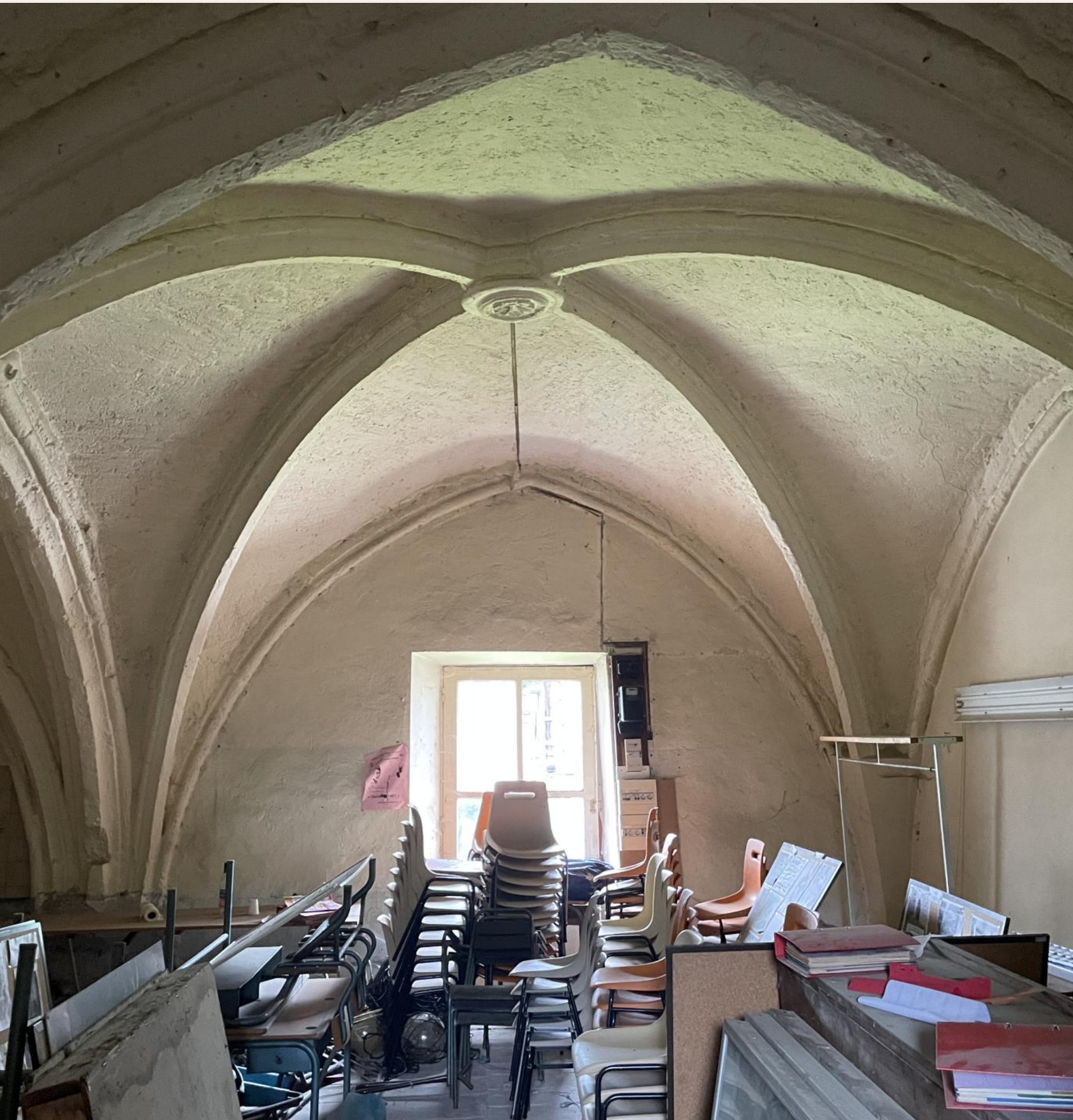
Les voûtes d'ogives de la salle capitulaire ; les fenêtres médiévales ont été recoupées à l'époque de la ferme.
